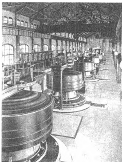
Niagara elektrostansiyasining turбина zali
